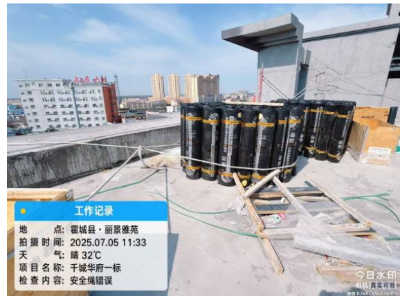
图 5.安全绳固定方式
