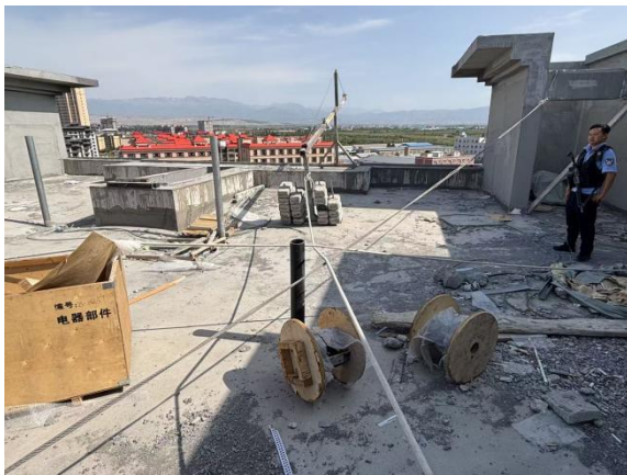
图 4.钢丝绳固定方式
